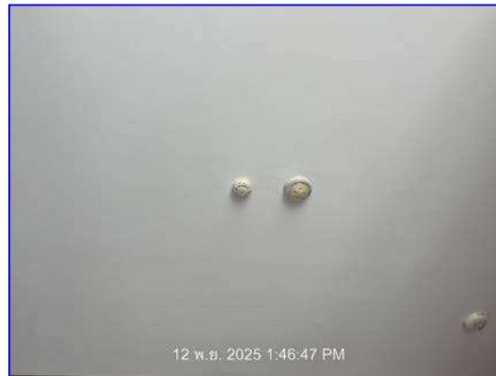
รูปที่ 2.25 อุปกรณ์ตรวจจับควัน
